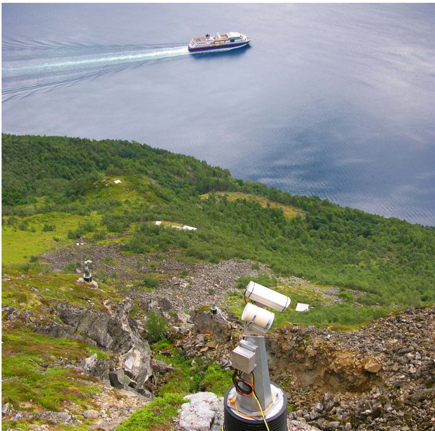
Det ustabile fjellpartiet ved Åknes. To lasere står i den faste delen av fjellsiden og måler avstander og bevegelser i det løse fjellpartiet. FOTO: Einar Anda/NVE.
